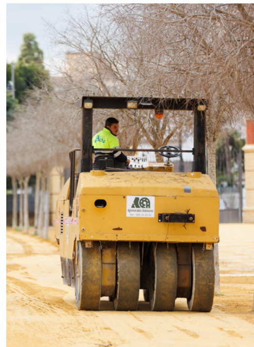
A la izquierda, el espectacular alumbrado. A la derecha, maquinaria trabajando en la mejora del albero.
