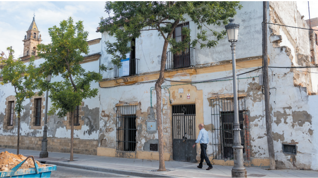
1. Obras de rehabilitación de un inmueble en calle Taxdirt.
