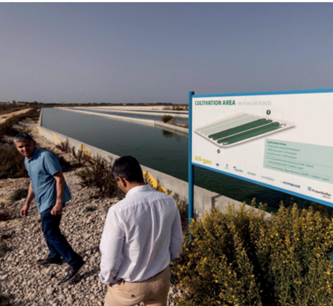
1. Arbib y Maikel, en las instalaciones de la EDAR El Torno, en Chiclana, sede del proyecto All Gas.
