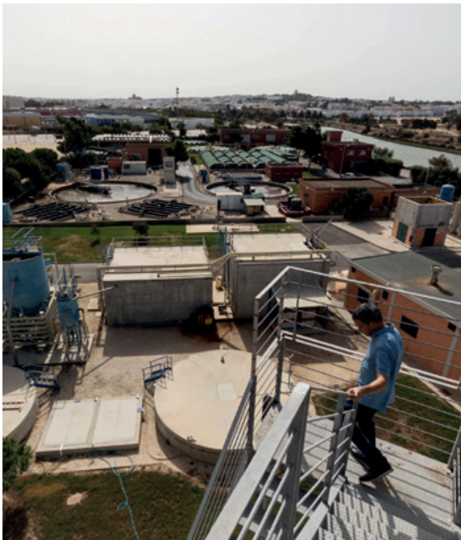
1. Vista general de las instalaciones donde se desarrollan las distintas fases del proyecto.
