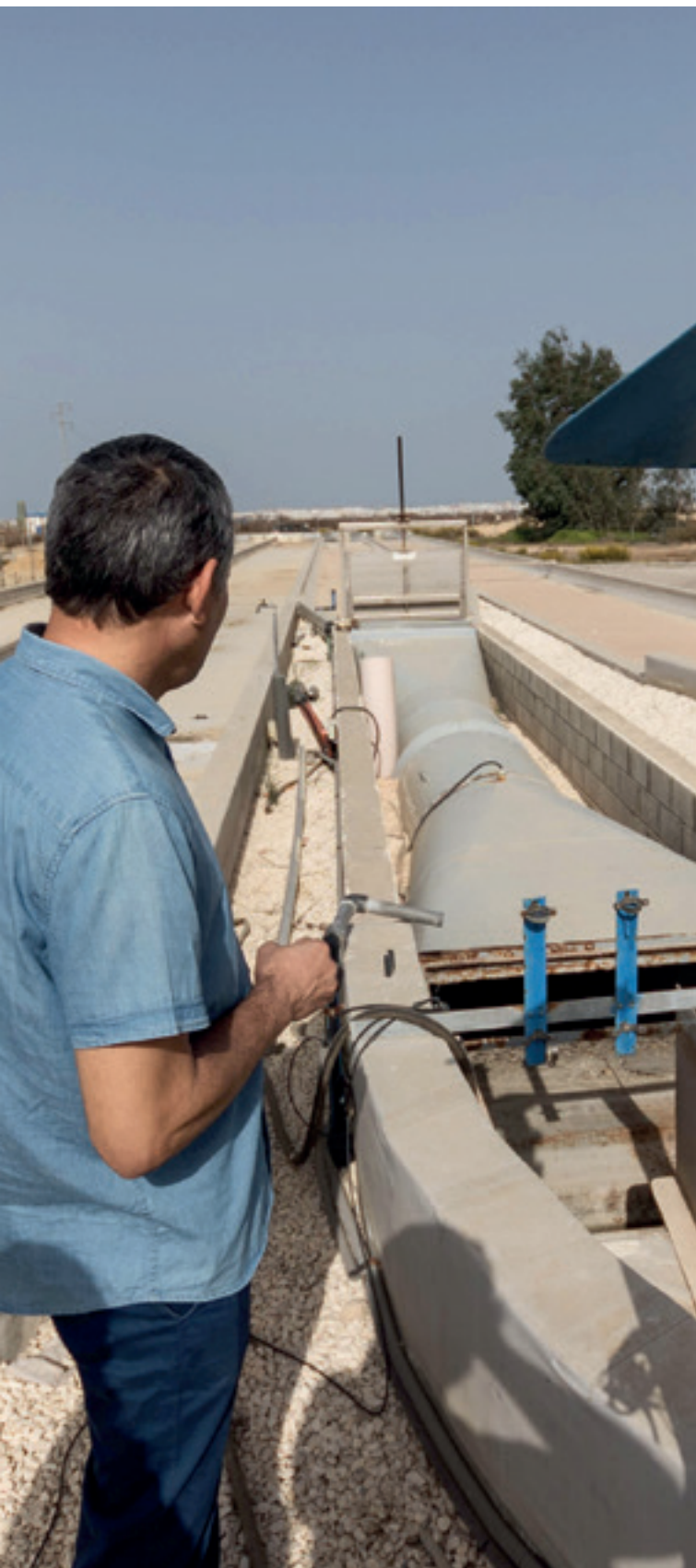
Maquinaria utilizada durante el desarrollo del proyecto.
